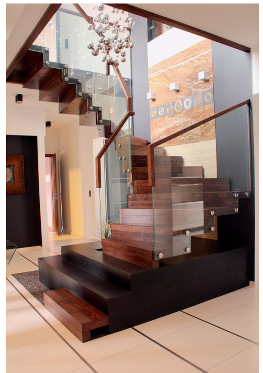
Die Tritt- und Setzstufen gehen bei der Falwerktrappe nahtlos ineinander über. Das erzeugt die Optik eines gefalteten Stückes Holz. (Foto: STREGER)
