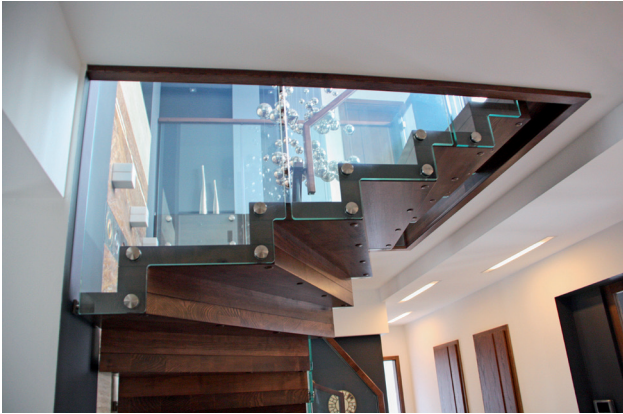
Das Brüstungsgeländer ist mit VSG-Sicherheitsglas gefüllt und folgt an der Unterkante exakt dem Steigungsverlauf der Treppe. (Foto: STREGER)
