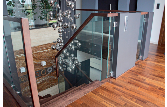
Betonelemente, die das Sicherheitsglas mit Glashaltern tragen, ergänzen das Geländer im Obergeschoss. (Foto: STREGER)
