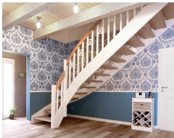
Die Wangentreppe im Landhausstil ist robust und sicher. Sie wurde aus heimischem Holz gefertigt und mit Ölen und Wachsen auf natürlicher Basis endbehandelt. (Foto: STREGER)
