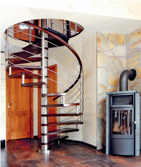
Da die Stufen an der Edelstahlsäule und nicht an der Wand befestigt sind, lässt sich die raumsparende Spindeltreppe flexibel platzieren. (Foto: STREGER)
