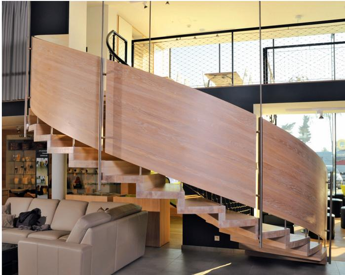
Auf 18 Stufen und mit einer halben Wendelung geht es auf der individuellen faltwerkterpreppe aus dem Hause STREGER hinauf und hinab. Die Treppe wurde als Bausatzsystem geliefert und in kurzer Zeit montiert. (Foto: STREGER)
