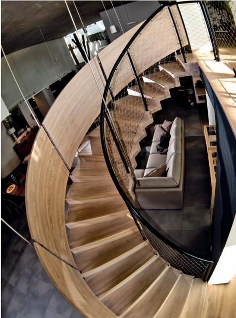
Das äußere Geländer besteht aus gebogenen, blickdichten Holzplatten. Im Gegensatz dazu ist das innere Geländer mit seinen metallenen Pfosten und Handlauf in Verbindung mit den Edelstahlnetzen transparent und lichtdurchlässig.
