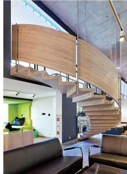
Die STREGER-Faltwerkterpreppe hängt an drei, in die Stahlbetondecke eingegossenen Anker. Durch diese Art der Befestigung macht sie den Eindruck, als würde sie schweben. (Foto: STREGER)
