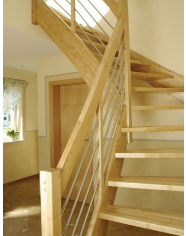
Eine strapazierfähige Oberflächenbehandlung, beispielsweise mit Lack oder mit Hartöl und Hartwachs, schützt das Holz vor Beschädigungen und fördert eine lange Haltbarkeit. (Foto: STREGER)
