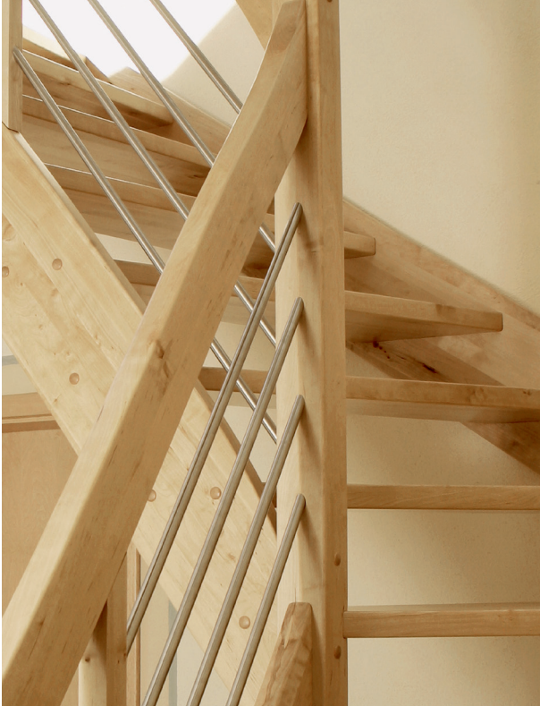
Waagerechte Edelstahlrohre bilden die Geländerfüllung. Sie heben sich dezent von den Zwischen- sowie Hauptposten aus dem nachwachsenden Rohstoff Holz ab. (Foto: STREGER)
