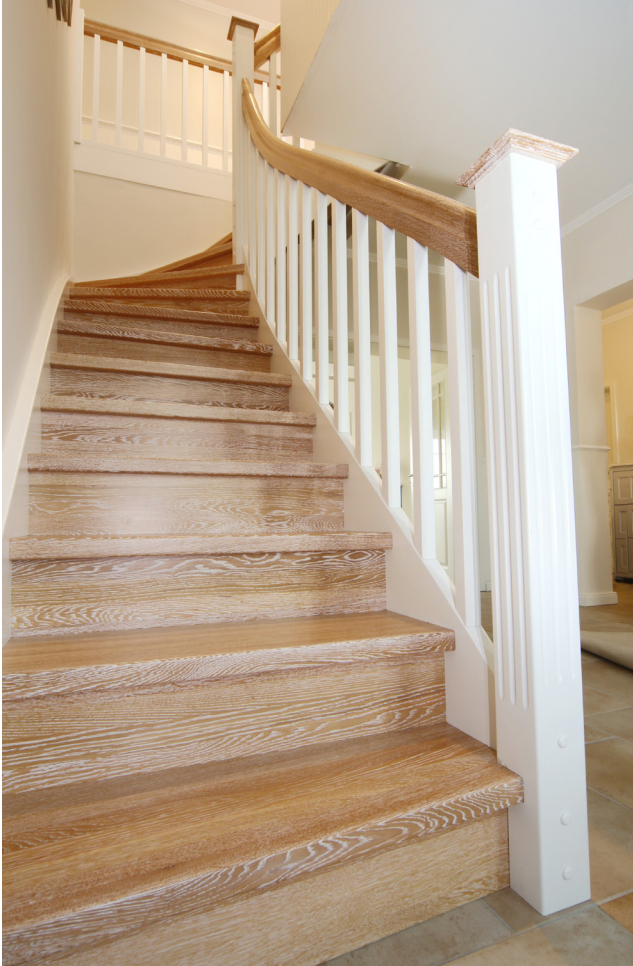
Selbst individuelle Kundenwünsche sind realisierbar: Der Sonderposten am Austritt dieser Treppe ist eine Spezialanfertigung. (Foto: STREGER)
